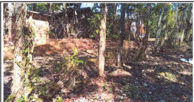
Foto 5: Se observa el caimiento y deterioro de las orcones o bases de las de las mallas.
